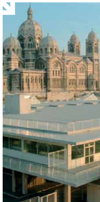
Le PAM a investi 16 M€ pour la construction de la gare de la Major. The PMA invested 16 M€ in the construction of the "La Major" terminal.
