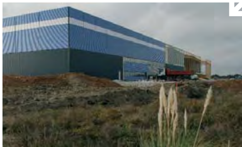
L'entrepôt Gazeley, sur le complexe logistique de Fos Distriport. The Gazeley warehouse, in the Fos Distriport logistics complex.
